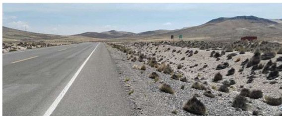
2. Red vial asfaltada
